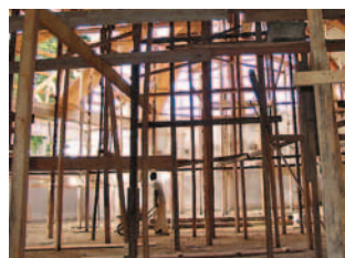
Die neue Kirche von Nnom-Nnam im Bau.
