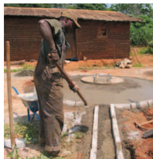
Fast fertig: Brunnen Nr. 1002 in Nyomo-Asi erhält eine Beton-Abdeckung.
