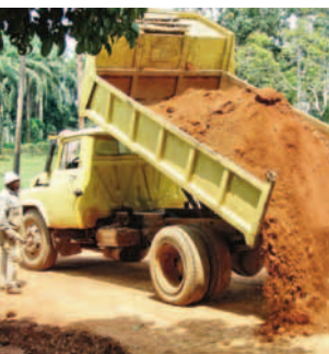
Unterhaltsarbeiten auf der wichtigen Verbindungsstrasse nach Yaoundé.
