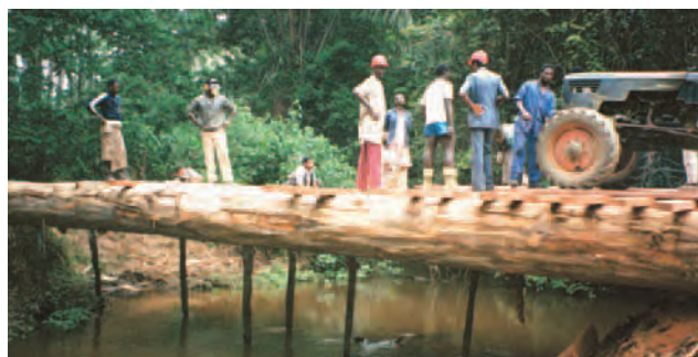
Verlegung der Querbalken
